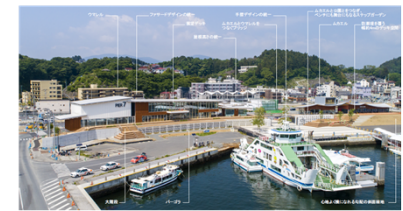
ムカエルとワマレル、防潮堤や岸壁が一体となったランドスケープ
