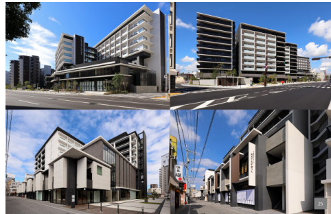
外観写真（上段：大通り側／下段：商店街側）
