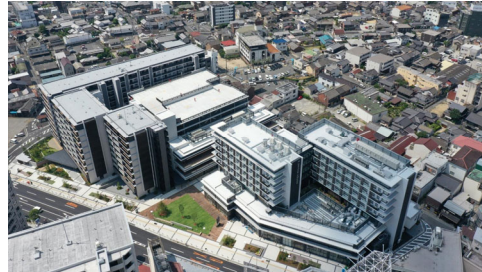
外観写真（右側：北棟／左側：南棟）
