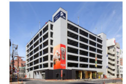
センテラスパーキング完成写真
