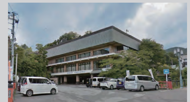
改修前：新耐震と旧耐震の混在した公民館
