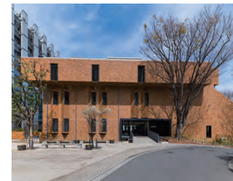
新設エントランス
