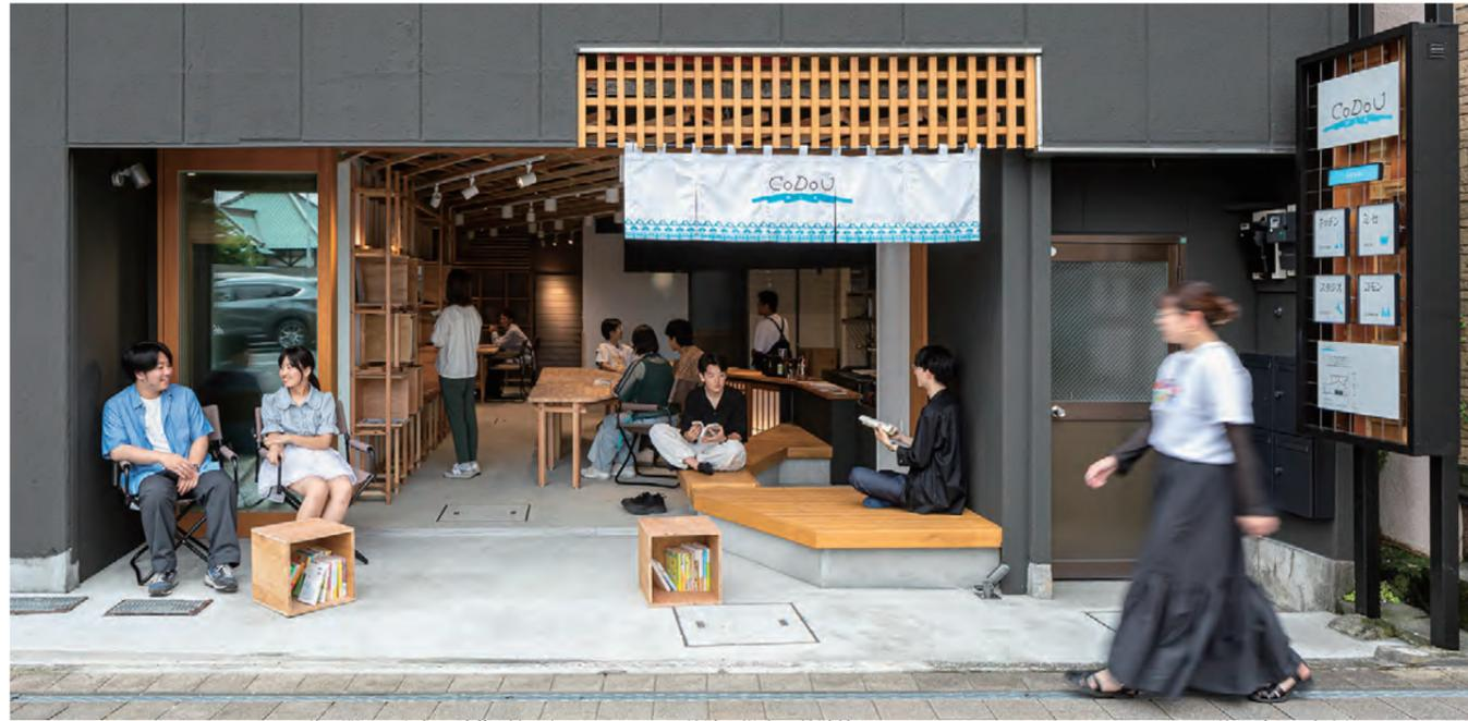
元々1階は閉じた印象の建物（左下）だったため、外壁を撤去、外壁線をセットバックさせた上にフルオープン可能な建具と縁側スペースを設置した
